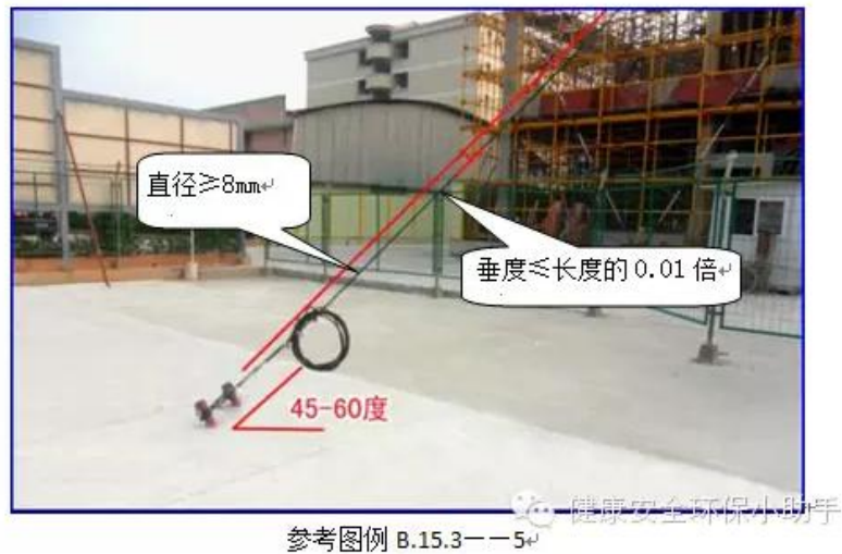
钢丝绳规格、安装角度推荐做法
