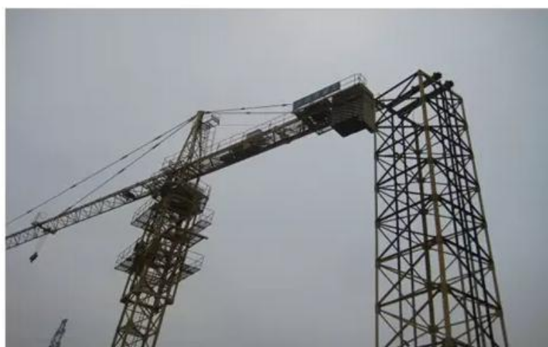
物料提升机在旁边塔机的保护范围之内，不需要装设防雷装置。 参考图例 B.15.10—2
